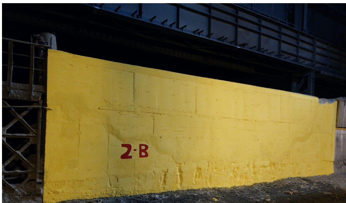
Figura 23 – Parede da baía de escória após recuperação
