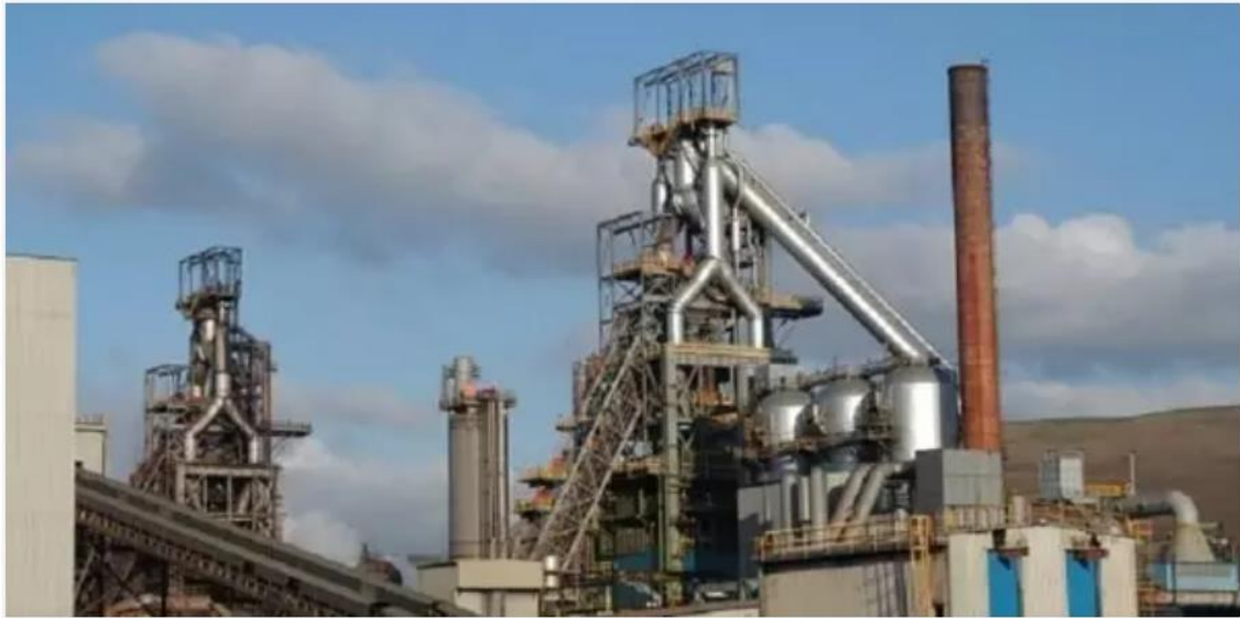
Figura 2 - Alto forno: usado para fundição e produção de gusa líquido.
