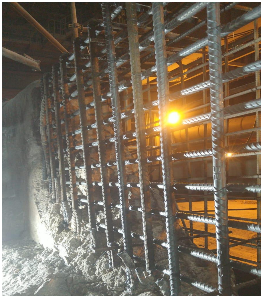
Figura 21 - Ancoragem de novas barras para recuperação da estrutura
