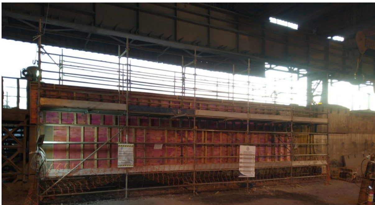
Figura 22 - Estrutura com formas montadas para receber a concretagem
